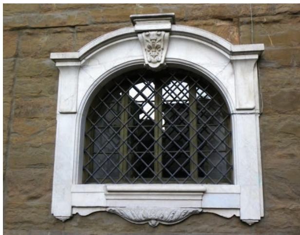
53 – Cappella dei Principi ve Florencii, detail okna
