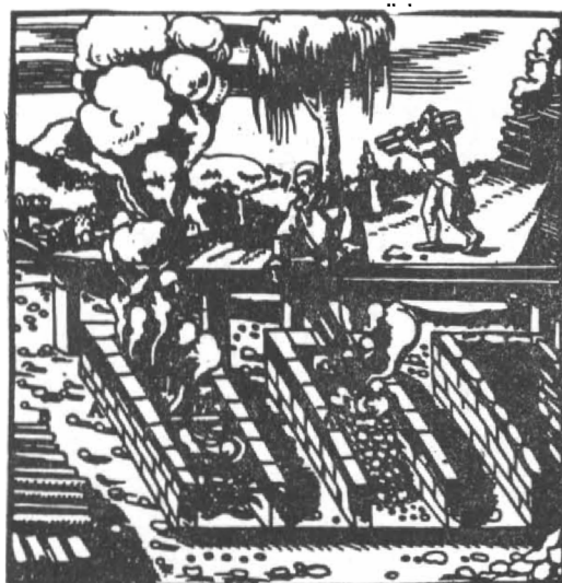
Obr. 9. 1–3 – metalurgická pec (štádlo), 4 – vyobrazenie štádla podľa Agricolu z r. 1556, 5 – zaoblený kus železa, pravdepodobne lopatky (z pece).
