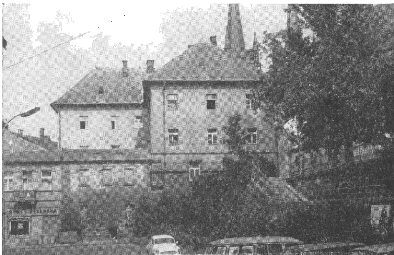
Obr. 5. Chrudim hrad, dnešní stav domu čp. 57/1, který obsahuje pozůstatky ohrazení a budovy prvního nádvoří hradu. Pohled od východu. Foto T. Durdík.
