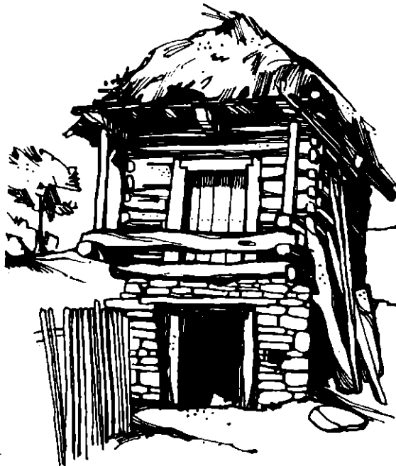
23. Roubená komora s kamennou podezdívkou, Žilková, o. Uheraké Hradillě, stav 1950. Kresba J. Kiese Wetter.
