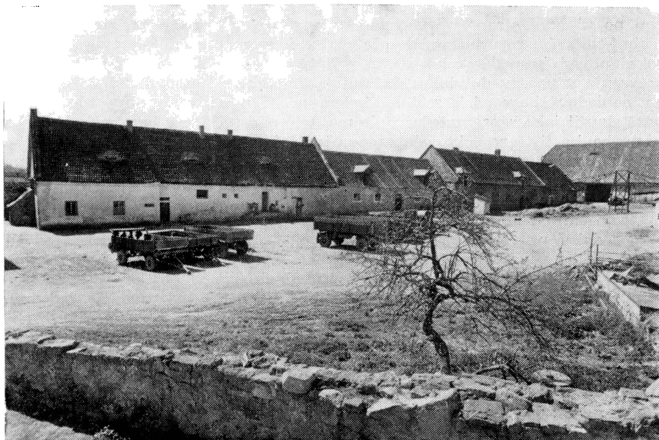
Obr. 12. Kestřany – pohled na jižní křídlo hospodářského dvora s bývalou ratejnou a vepřínem, patrně renesančního původu, mladší teletník, klasicistní šrotovnu a barokní stodolu. (Foto V. Uher)
