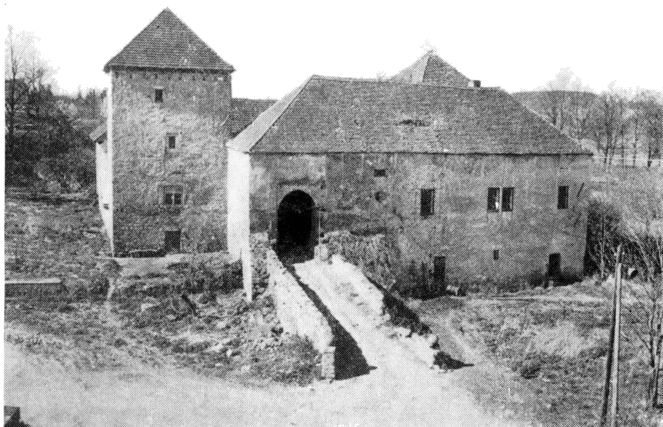
Obr. 9. Kestřany – Horní tvrz při pohledu z 2. patra zámku, stav před započítím zabezpečovacích prací. Sondy zachytily fragmenty trojdielných oken čelního paláce, na nárožní věži dochovány kapsy vzpěr bývalé hrázděné nástavby. (Foto V. Uher)
