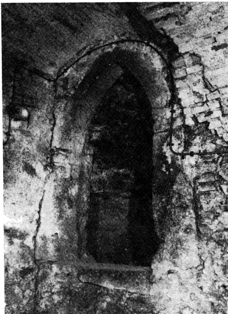
Obr. 5. Kamenný podklenutý pás v spodnom podlaží objektu Nálepková 16, ktorý nesie priečku horného podlažia. Nad vrcholom oblúka je viditeľná pôvodná úroveň podlahy horného podlažia. Klenba je ranorenesančná. Foto: J. Schramek.
