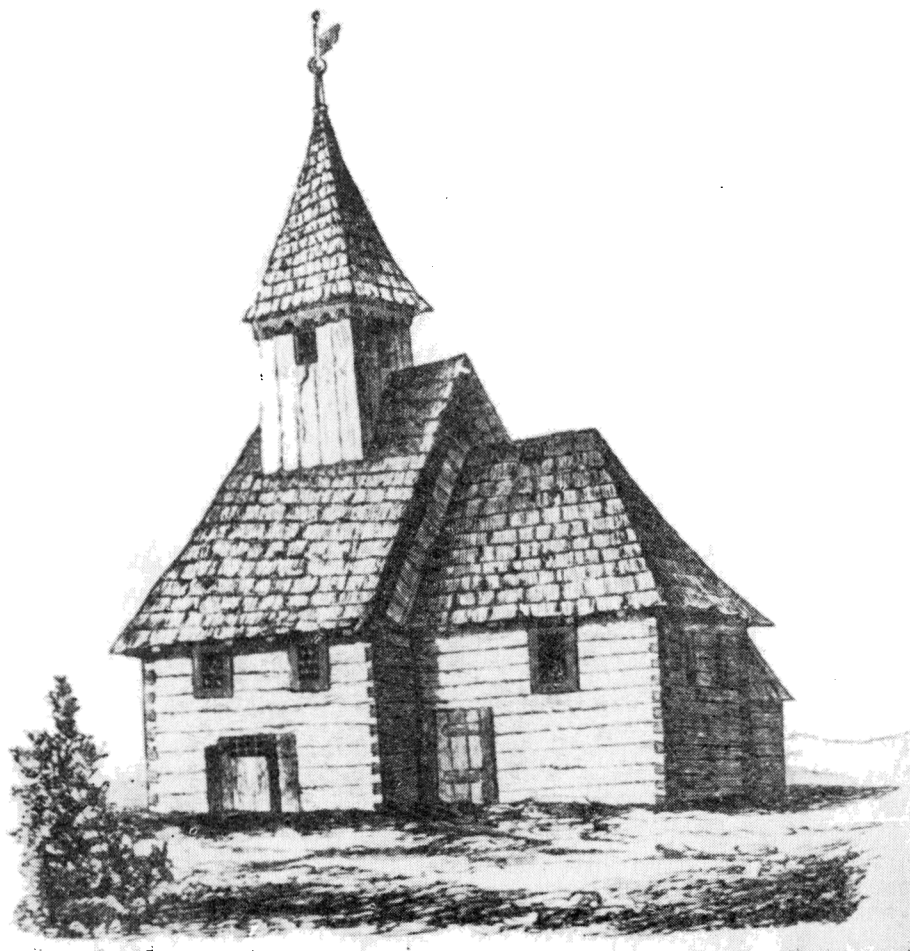
Obr. 6. Příklad dřevěné sakrální architektury jednoduchého půdorysného schématu s dobře patrnými prvky dispozice i detaily stavební technologie (roubená, v rozích přeplátovaná konstrukce stěn). Zaniklý kostel Nanebevzetí Panny Marie v Sádce u Opavy, 16. století, podle W. Merklase. Reprofoto J. Chlumská.
