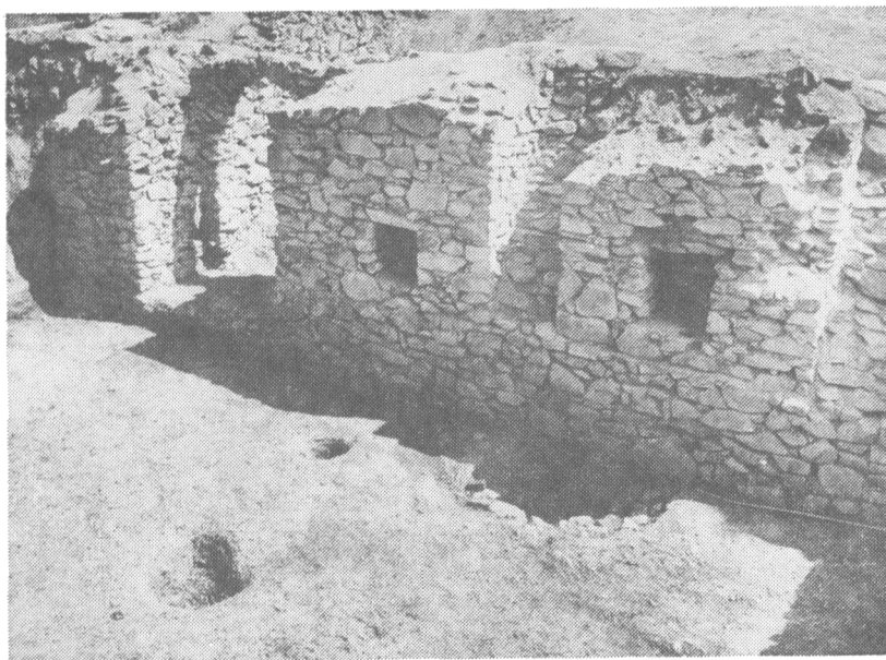
Obr. 3. Lelekovice-hrad. Sklep E od jihozápadu se vstupem, výklenky, šikmými okny a jímkou.
