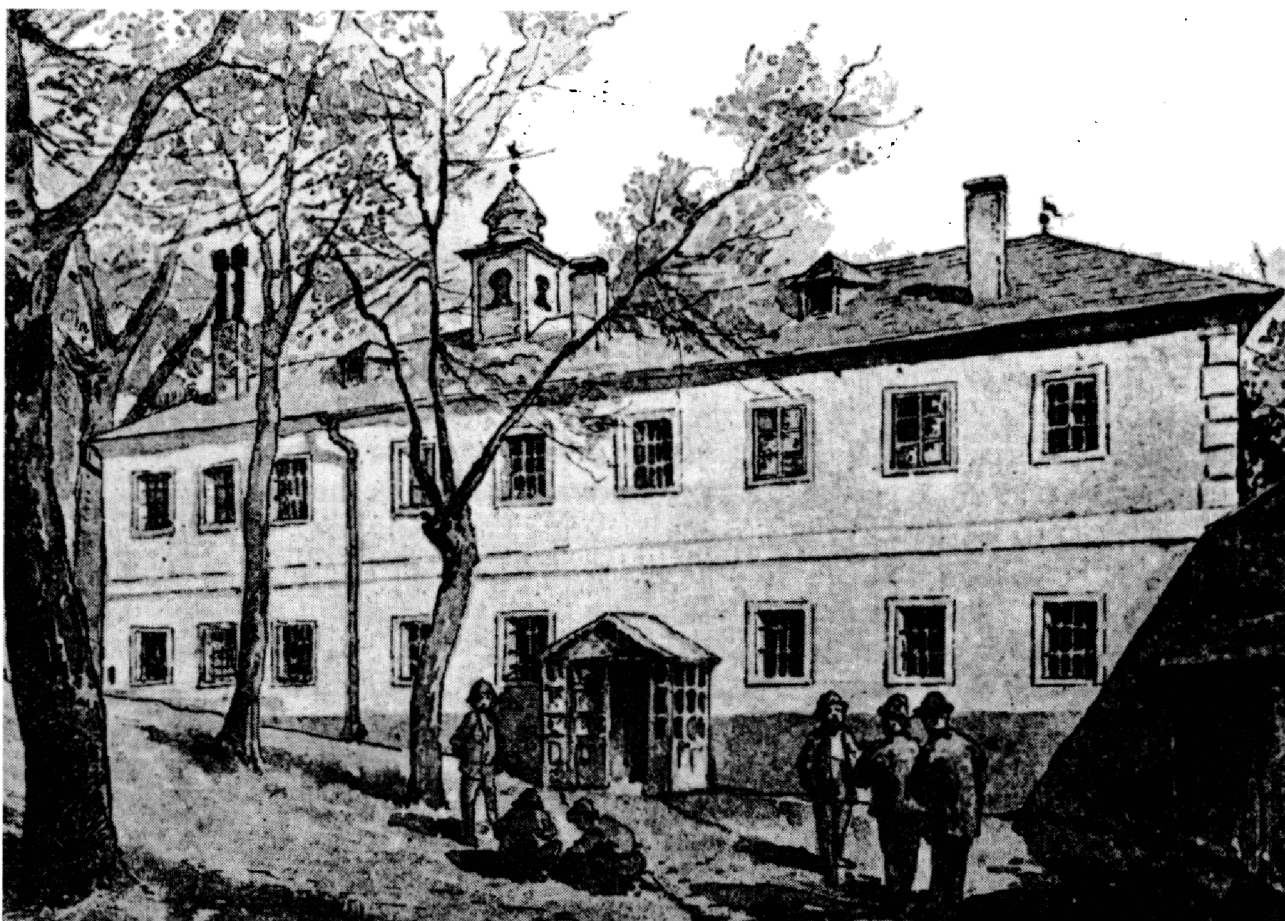
Obr. 9. Západné priečle budovy gymnázia z konca 19. stor. – pôvodne hlavná kláštorná budova.
