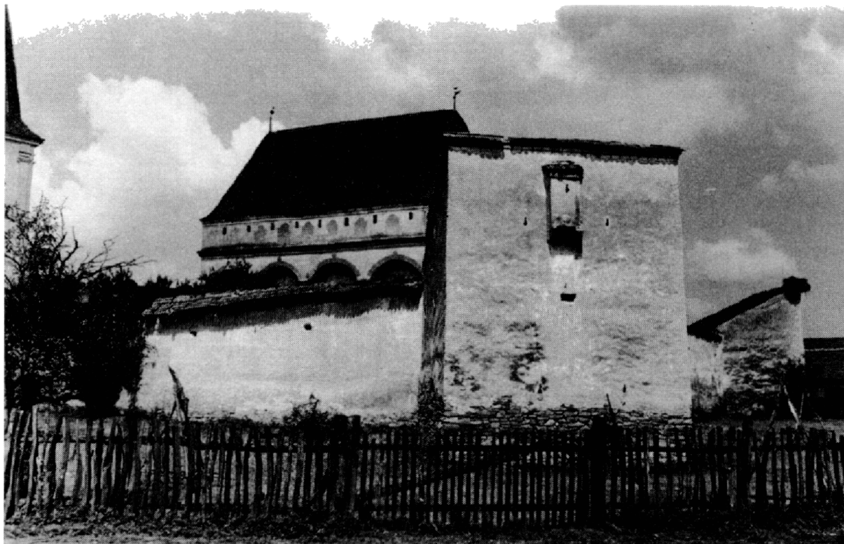
Obr. 10. Cloašterf (Klosdorf), nároží věže nakoso a kostel s obrannou chodbou na obloucích opěrných pilířů.
