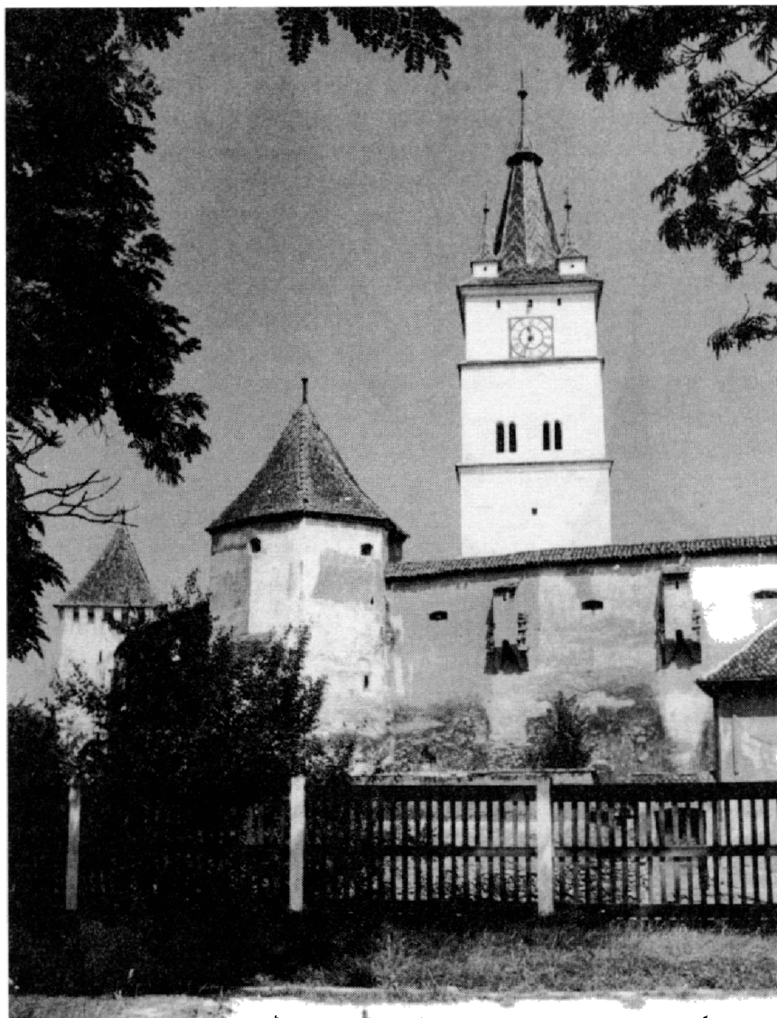
Obr. 8. Harman (Honigberg), jihozápadní část okružní zdi s hradebními věžemi a smolnými nosy.
