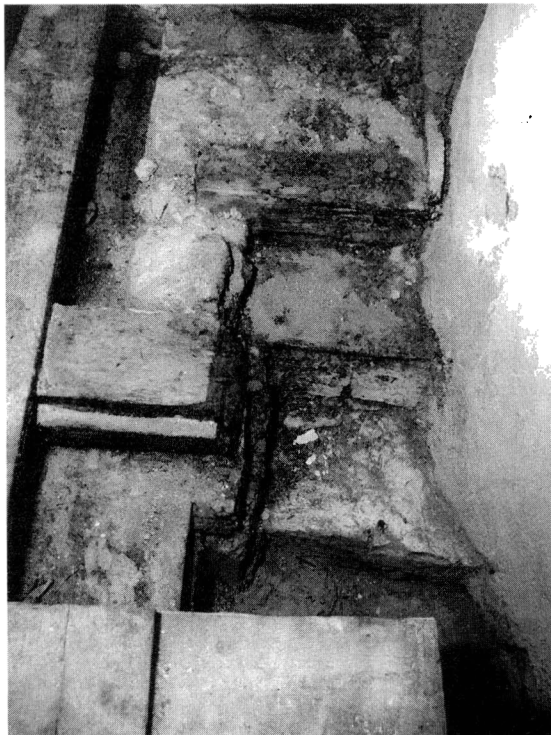
Obr. 8. Časť barokových schodov v hmote muriva portálového výstupku nad pravou stranou archivolty.
