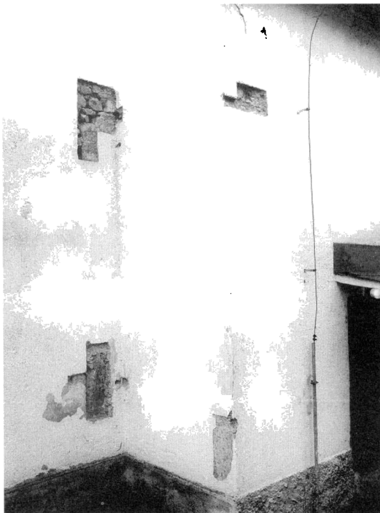
Obr. 7. Sondy na južnej stene veže, v špáre nárožie portálového výstupku.
