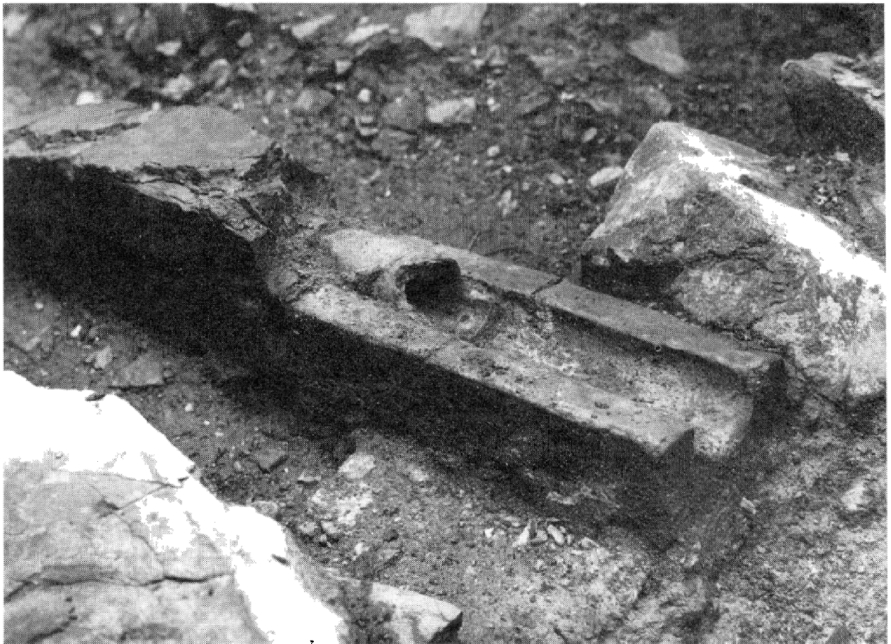
Obr. 7. Křivoklát hrad, okr. Rakovník. Část keramického vodovodu v místě jeho prostupu hradbou mezi velkým a studničním nádvořím dolního hradu. Foto K. Vlček.
