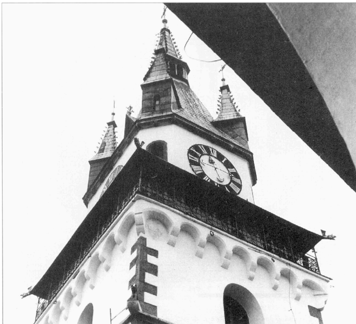
Obr. 2. Detail siedmeho poschodia veže s ochodzou.
