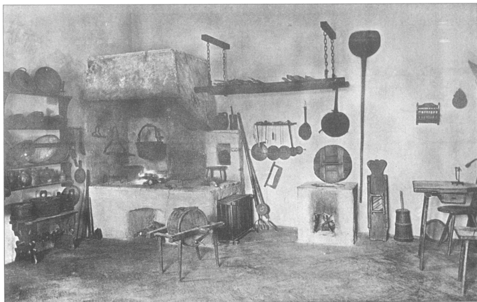
Obr. 3. Výřez pohledu do interiéru dýmné jizby štýrského domu, instalovaného na počátku 20. století v expozici Landesmuseum ve městě Graz. Před čelist chlebové pece je předsunuto otevřené ohniště, nad kterým je umístěn koch na odvod dýmu. Nad ohništěm je zavěšen kotel, hrnce při přípravě jídel na otevřeném ohni stály na trojnožkách, ze kterých bývaly snímány pomocí vidlice. Nádoby, ve kterých byly pokrmy pečeny a dušeny v peci se do ní vkládaly i vyjímaly pomocí „vozičku“ – vidlice na kolečkách. Podle Ch. Holma 1911.
