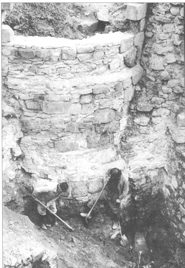
Obr. 10. Hrad Lukov – rozšířený základ (talus) románské břitové věžice – pohled od západu. Zajišťovací sondáž v roce 1989. Foto J. Kohoutek, 1989.
