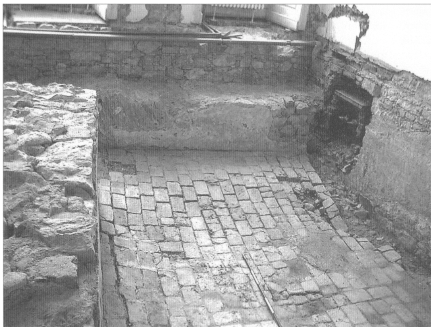
Obr. 3. Praha-Hrad, čp. 2/Tereziánský ústav šlechticů. První suterén. Zaniklá místnost jižního křídla domu pánů z Vamberka. Pohled od severu.
