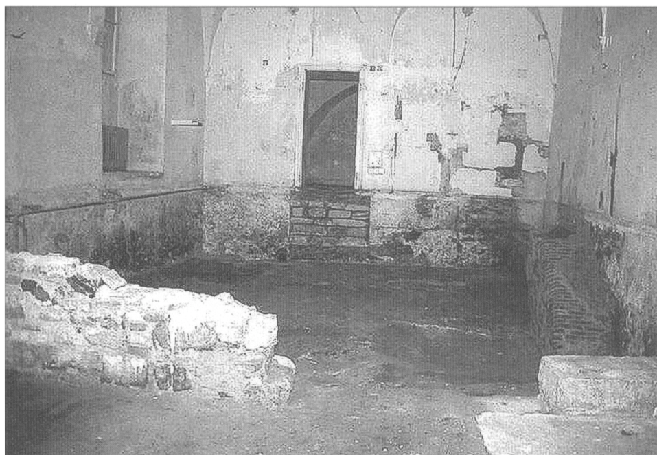
Obr. 4. Praha-Hrad, čp. 2/Tereziánský ústav šlechticů. Severovýchodní nárožní místnost původního Rožmberského paláce po odstranění novodobých násypů. Pohled od západu.
