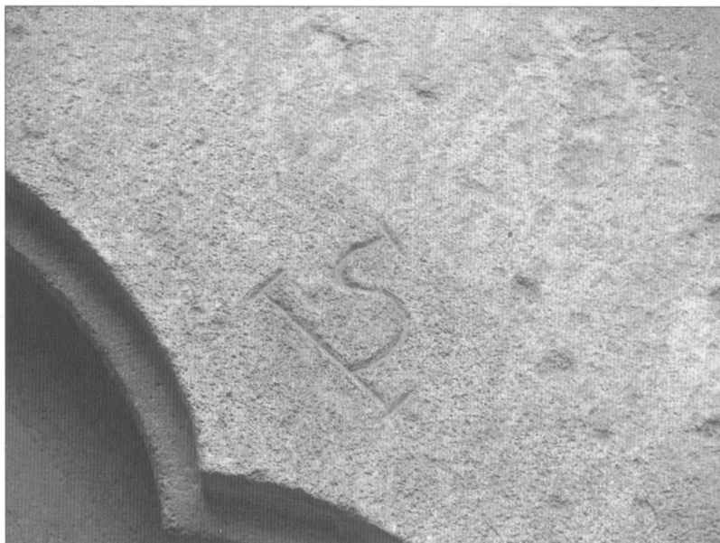
Obr. 12. Brno, sedile v nádvoří areálu jezuitského kostela Nanebevzetí P. Marie, díve ženský klášter řehole sv. Augustina - kamenická značka (foto Z. Vácha).
