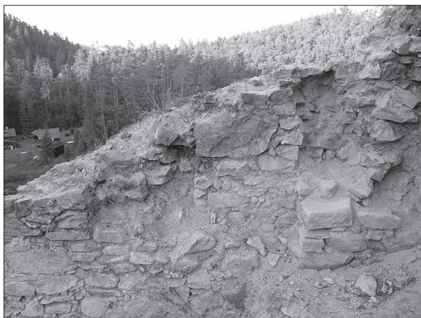
Obr. 8. Pořešín hrad, okr. Český Krumlov. Třetí brána. Nahoře celkový pohled od západu. Ve středu čelní pohled, dole vnitřní líc východní zdi předbrány s dobře patrnými třemi stavebními fázemi. Foto D. Polcar.
