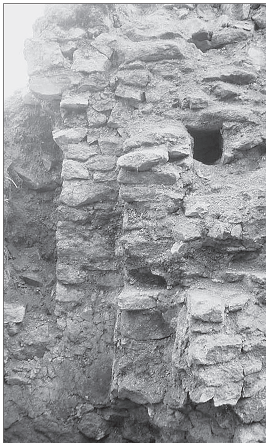
Obr. 7. Pořešín hrad, okr. Český Krumlov. Třetí brána, východní špaleta. Nahore celkový pohled, dole detail negativu ostění kapsy závory a nejstarší zdi předbrani s ústupkem pro osazení konstrukce padacího mostu (vlevo). Foto autor a D. Polcar. Abb. 7. Burg Pořešín, Bez. Český Krumlov. 3. Tor, Ostgewände. Oben, Gesamtansicht, unten, Detail des Negativs der Riegelbalkentasche im Gewände und älteste Vortormauer mit Vertiefung für die Zugbrückenkonstruktion (links). Fotos Verfasser und D. Polcar.
