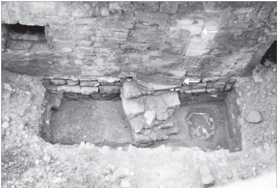
Obr. 5. Jižní obvodová zeď severního křídla hradu nad sondou 2/82. Nad pravým lícem vystupujícího základu zdi je patrná spára (viz šipky) se šmorcem zprava. Foto F. Gabriel.
