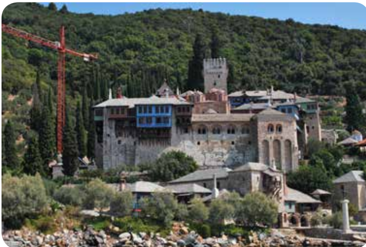
Foto 3. Jeřáb opravující hradební zdi a věže kláštera Dochiariou
