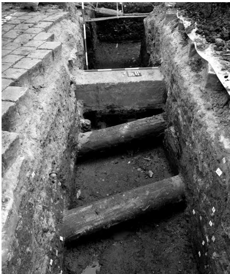
Obr. 11. Hradec Králové, Velké náměstí, 2020, stavba horkovodu, souběžně probíhající dřevěné vodovodní roury, raný novověk.
