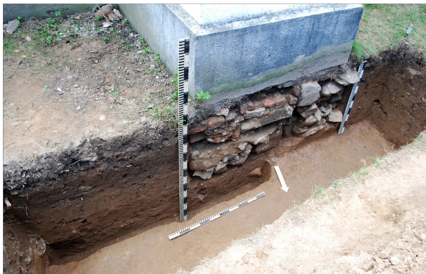
Obr. 26. Stredoveký kostol v Palad' Komarivci. Pôdorys a profil rezu 3 a nálezy z neho. a – povrchová vrstva šedej farby, b – hnedá hlina, c – homogénna svetlohnedá hlina, d – tmavá pôda so stavebnou suťou, e – založenie základu, f – tehly a kvádre z gotickej klenby, g – podlažie, h – obrysy severného oporného piliera; i – pravdepodobné obrysy základu sakristie; j – skúmaná úroveň.
