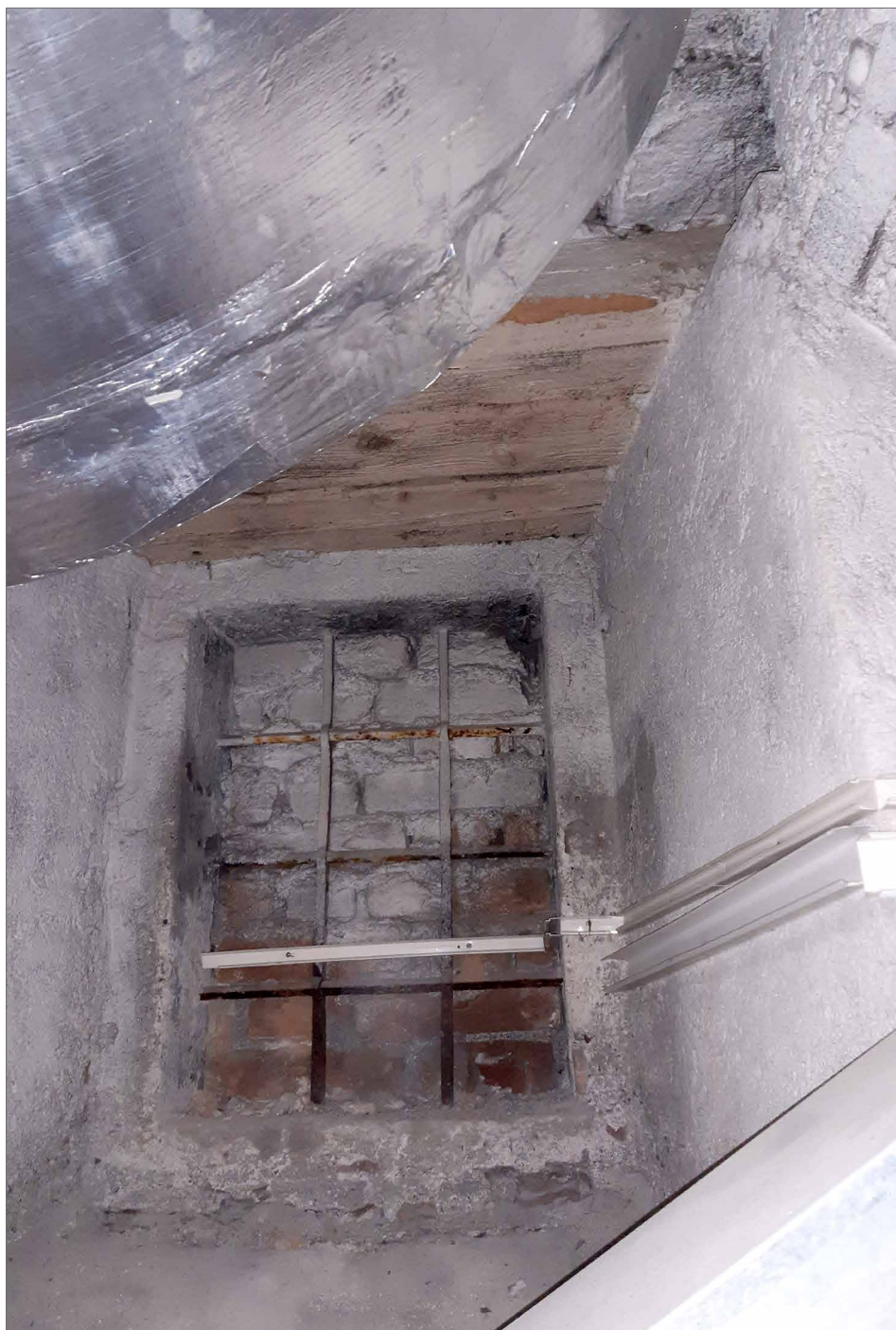
Obr. 8. Nová radnice v Brně – mezipatro pod tzv. rytířským sálem – dochované okno s kamenným ostěním a železnou mříží. Foto D. Janiš, 2023.
