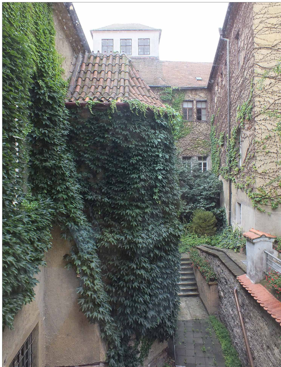
Obr. 7. Nová radnice v Brně – polygonální schodišťový přístavek přiléhající k severní části tzv. rytířského sálu. Foto J. Janišová, 2023.
