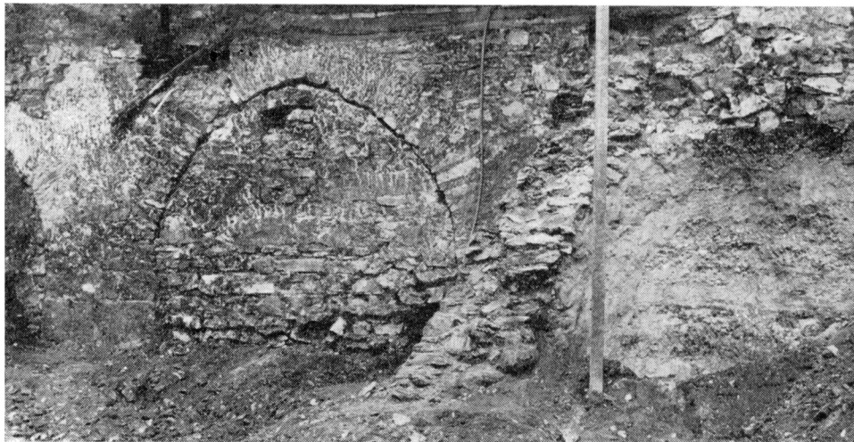
Obr. 2. Pohled na mostní oblouk s pilířem a opěrnou zdi příkopu. Stav před provedením sondy do dna příkopu.
