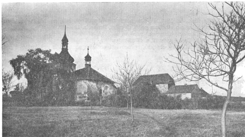
Obr. 6. Pohled na kostel a tvrz v Kopistech od východu, stav 1978 (foto K. Wartha).
