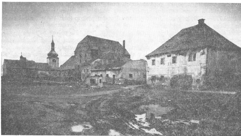
Obr. 7. Pohled na komplex tvrze v Kopistech od severu, stav 1978 (foto K. Wartha).
