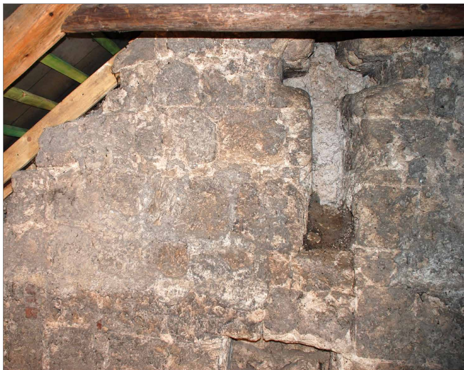
Obr. 8. Hrhov, detail kvádríkového muríva v murive východného štítu svätyně kostola s vetracím otvorom v tvare kríža. Foto P. Tajkov.
