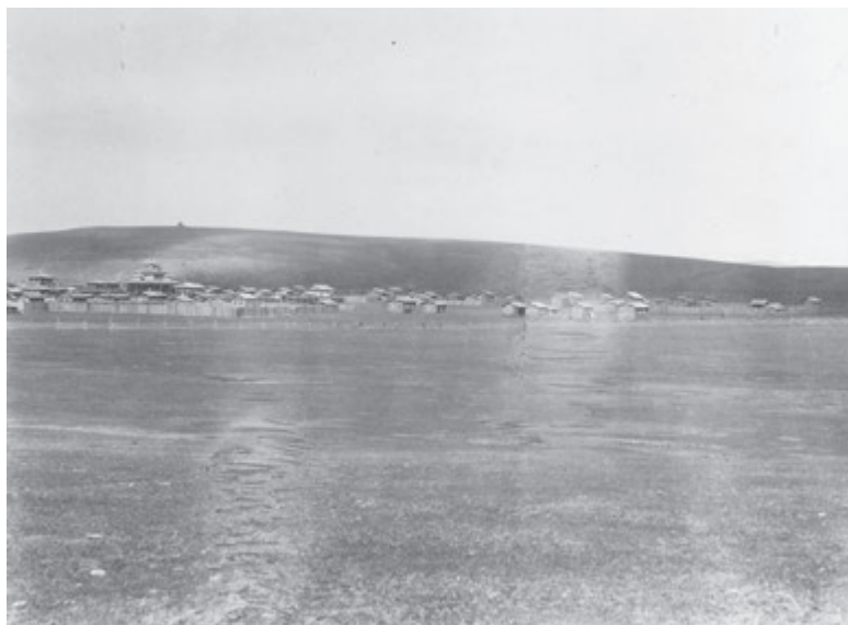
Obr. 9 – Původní Egitský klášter. Pohled na klášterní komplex, hlavní chrám z jihovýchodu, počátek 20. století.
