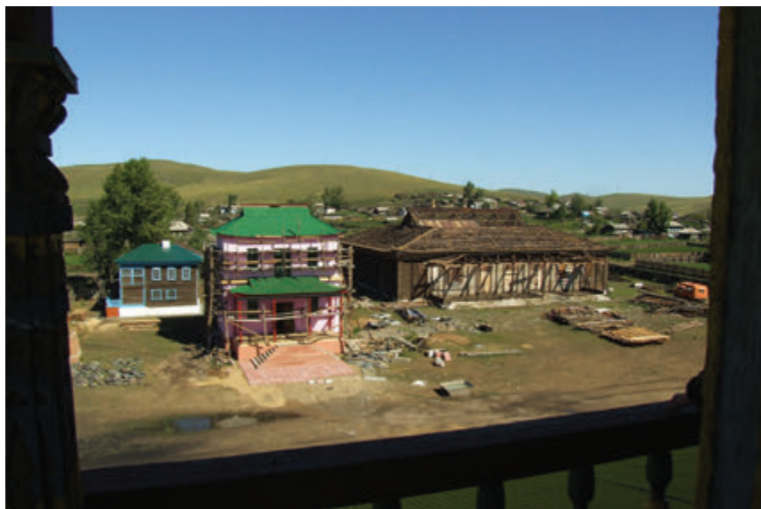
Obr. 57 – Stavební replika chrámu budoucího buddhy Maitréji v Cugolském klášteře. Stav v roce 2005.
