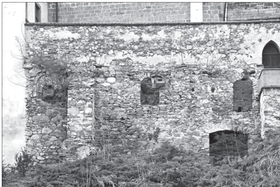
Obr. 2. Detail dokumentovaného úseku ohradní zdi areálu kláštera – někdejší převorství od jihu. Tmavě zvýrazněny okenní otvory fáze B. Foto archiv Archaia Brno, o. p. s.
