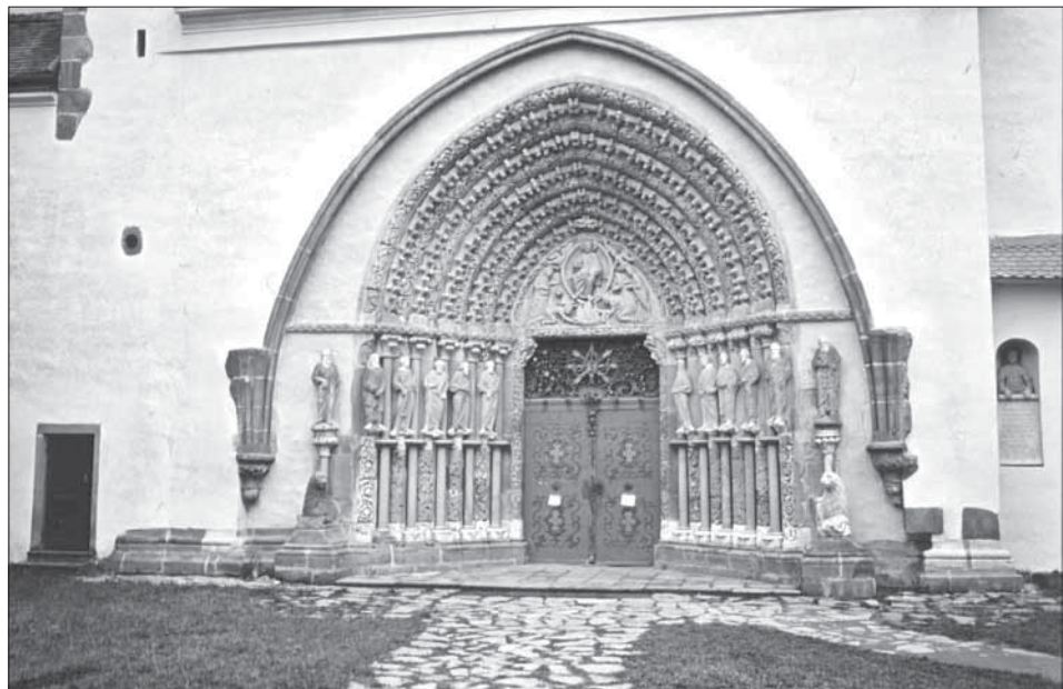
Obr. 9. Tišov, západný portál. Foto autor.
