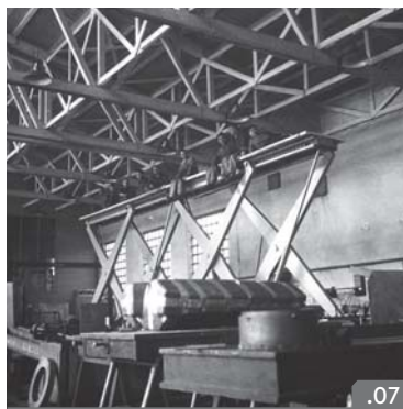
Laterna magika, mechanismus pro elevaci ploch a pódii
