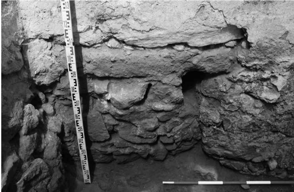
Obr. 5. Hronský Beňadik, Kostol sv. Egídia. Sonda III – základ západnej fasády pôvodného kostola s pristavanými múrmi veže (vľavo) a barokovým rozšírením lode kostola (vpravo). Foto M. Hanuš.
