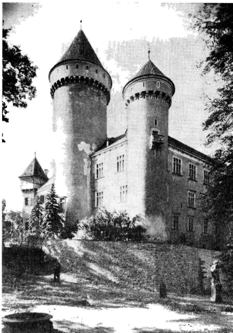
Obr. 6. Konopiště. Jihovýchodní průčelí – dnešní stav (foto J. Binko).
