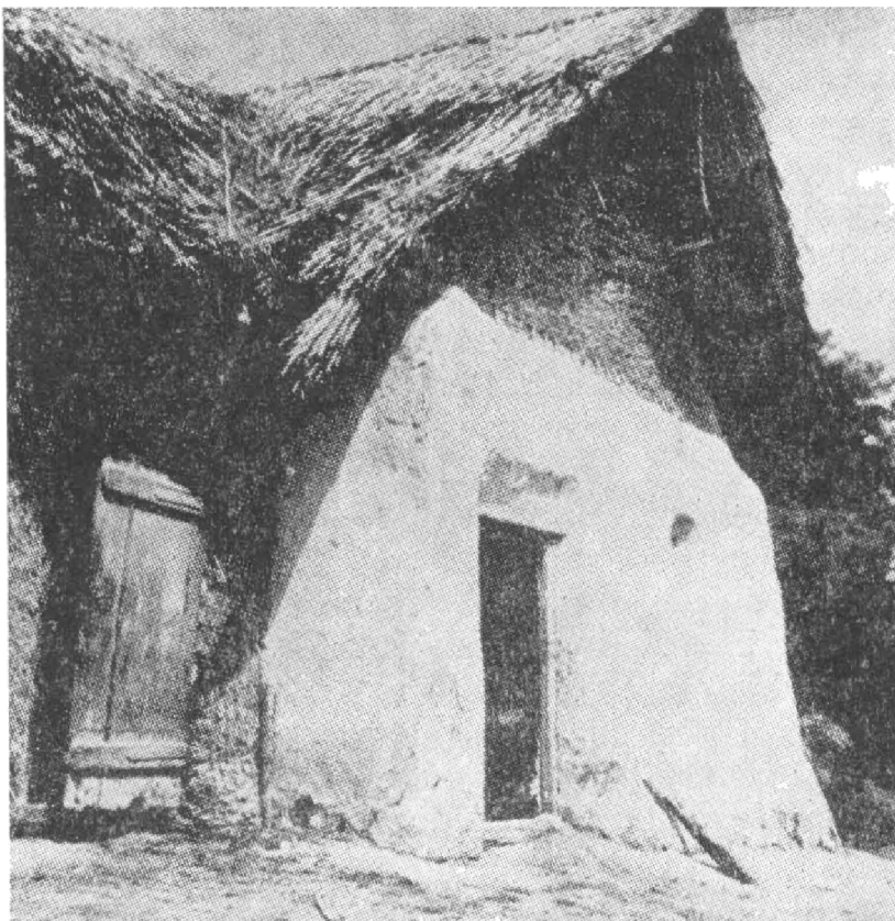
Obr. 13. Martovce. Komora s hlinenými stenami ako súčasť obytného domu. (Podľa V. Mencla).
