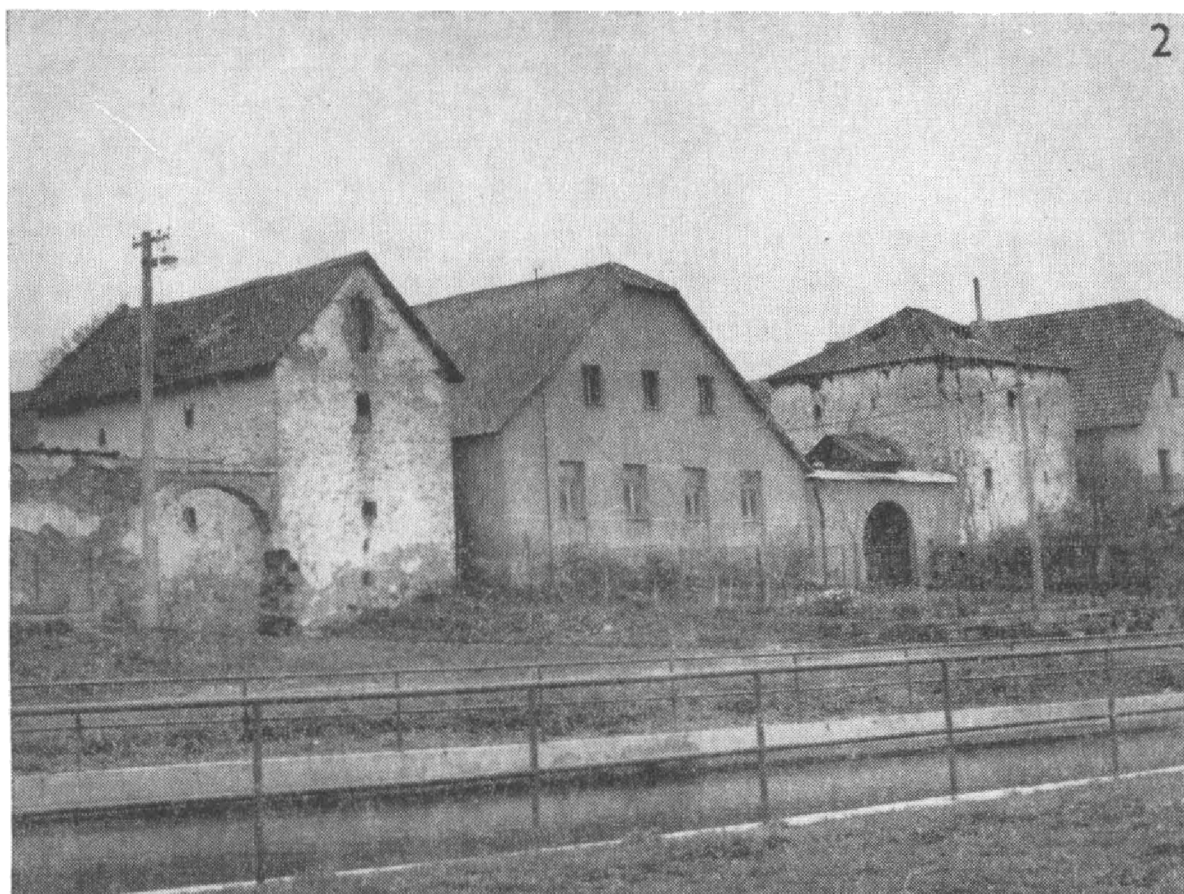
Obr. 15. Čížov (okr. Jihlava). 1 – vstupní portál do špýcharu, 2 – špýchary stojící v rámci vesnické zástavby.
