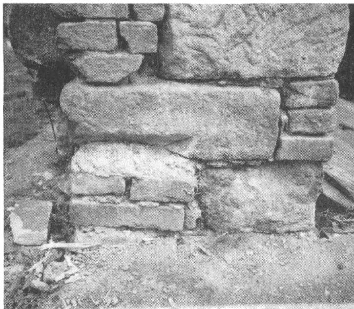
Obr. 7. Černice žp. 17. Zdivo u vjezdu do stodoly a části okoseného ostění.
