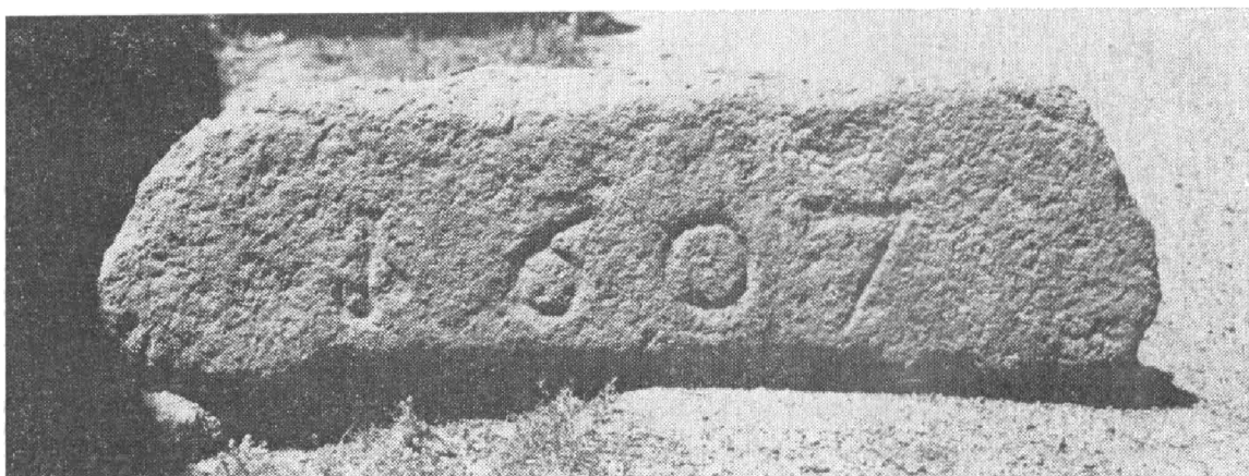
Obr. 30. Solopysky (PB) čp. 22. Překlad obdélného okoseného okénka s datováním 1607. Stav 1975.
