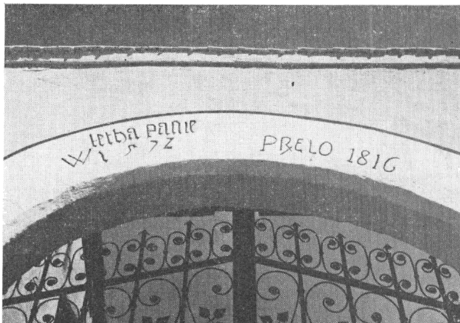
Obr. 16. Dublovice (PB) čp. 11. Detail horní části pozdně gotické brány s původním a mladším datovacím nápisem na kamenném ostění. Stav 1975.
