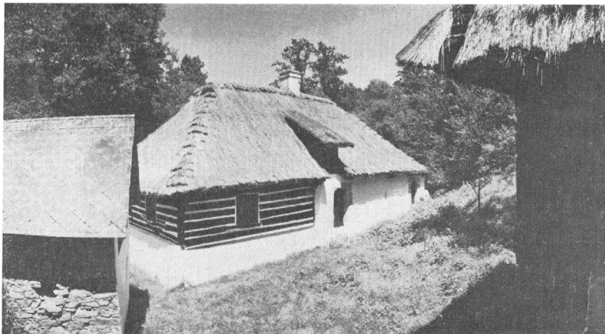
Obr. 1. Bláhova Lhota (okres Příbram) čp. 5 – mlýn. Celkový pohled na obytné stavení s pozdně gotickými portály do síně a mlýnice. Stav 1975.
