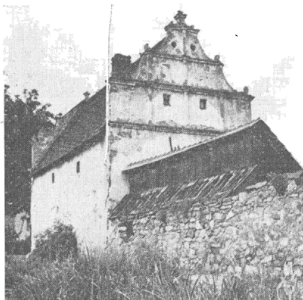
Obr. 28. Solopysky (PB) čp. 22. Celkový pohled na zděnou patrovou sýpku s renesančními štíty. Stav 1971.
