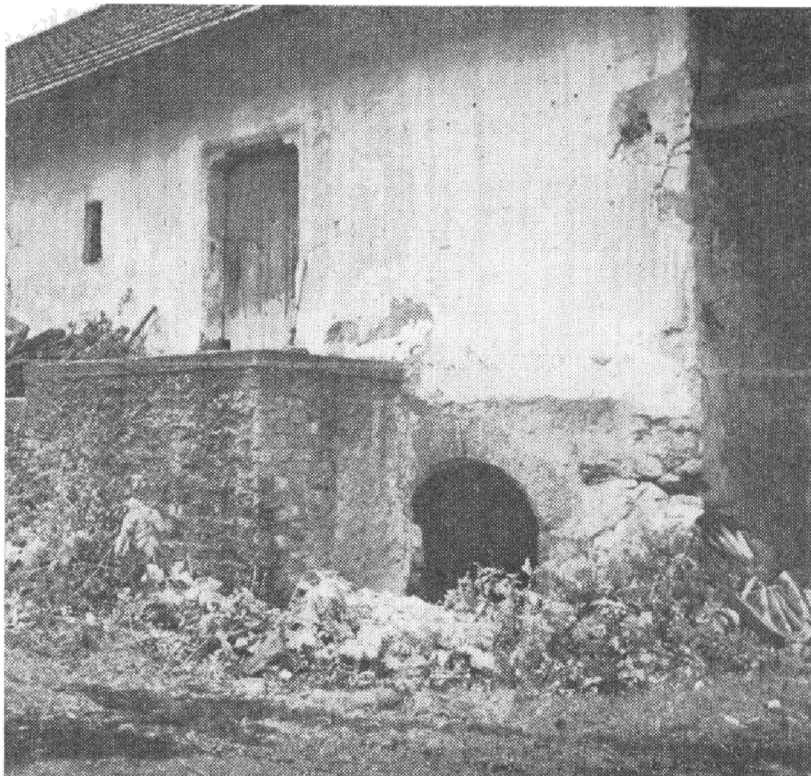
Obr. 3. Bražná (PB) čp. 6. Kamená dvoupatřížní sýpka se dvěma pozdně gotickými portály, původně možná zadní část obytného stavení. Stav 1981.
