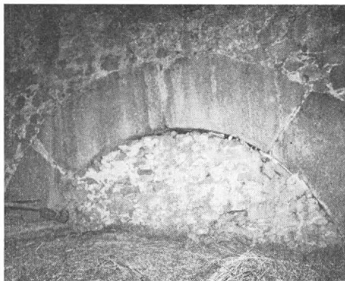
Obr. 7. Bražná (PB) čp. 10. Horní část lícové strany brány pod mladším přístavkem. Stav 1981.
