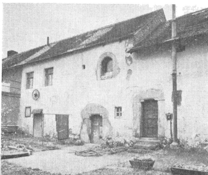
Obr. 17. Dublovice (PB) čp. 15. Celkový pohled na pozdně gotickou zadní část domu se dvěma sedlovými portály v přízemí a nově odkrytým portálem v patře. Stav 1981.
