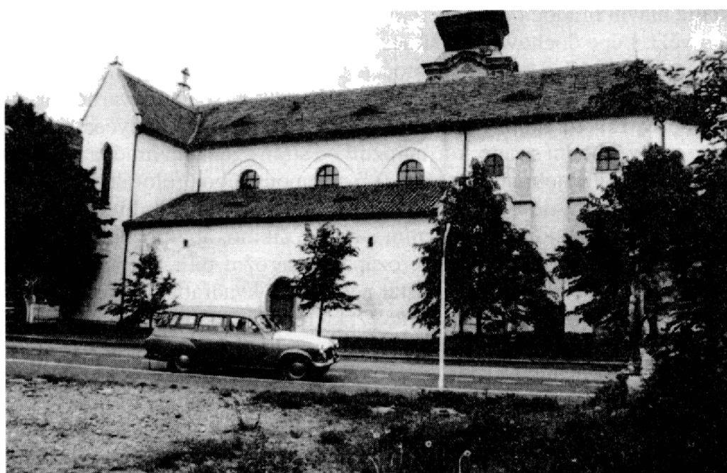
Obr. 7. Sušice, jižní průčelí kostela sv. Václava. Jižní stěna boční lodě ve středověku tvořila zároveň úsek městské hradební zdi. Pod pultovou střechou jsou vidět dvě střílny cimbuří, později zazděného. Foto autor, 1994.
