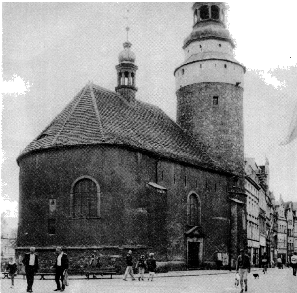
Obr. 10. Jelenia Góra v Dolním Slezsku. Válcová věž Wojanovské brány, před níž stojí kaple sv. Anny. Kaple údajně vznikla adaptací bašty již roku 1514, tedy v době funkčního období městského opevnění (přestavba počátkem 18. století). Foto autor, 1995.
