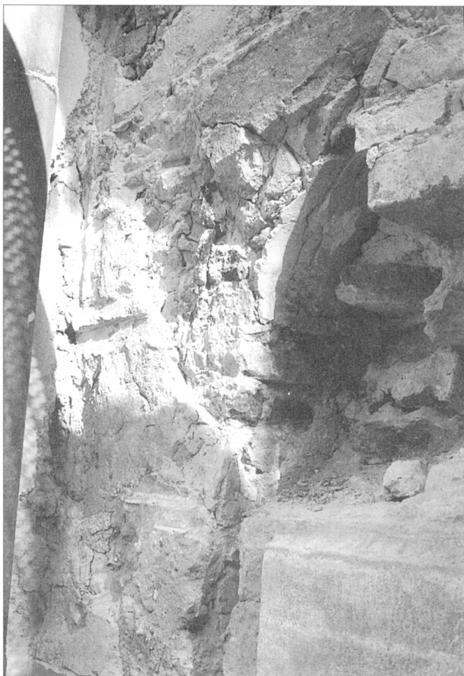
Obr. 4. Uličné priečelie Michalskej č. 6 v Bratislave. Sonda odкрýva osekaný arkier s omietkou v ostení záklenku.
