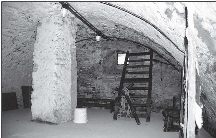
Obr. 6. Jeseník, zámek, velký pozdně středověký sklep pod jižním dílem východního křídla s druhotně vloženým pilířem, stav v roce 2006. Foto Dalibor Prix.
