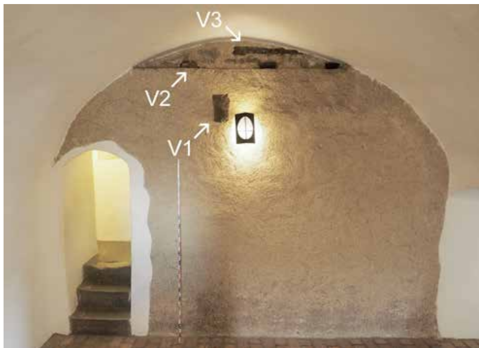
Obr. 4. Trenčiansky hrad. Severná stena 3. NP veže s vyznačením vzoriek stavebných drev. Foto M. Bóna. Abb. 4. Burg Trenčín. Nordwand 3. OG des Turms mit Kennzeichnung der Bauholzproben. Foto M. Bóna.
