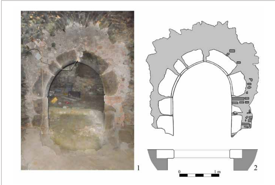
Obr. 4. Šumperk. Pozdně gotický pískovcový portál ve sklepě domu. Bílá – kámen, světle šedá – malta, tmavě šedá – cihly. Kresba a foto L. Hlubek.
