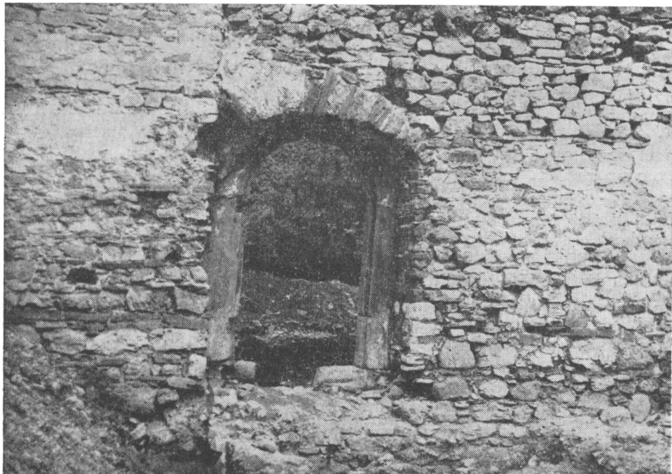
Obr. 3. Cezúra v západnom obvodovom múre-interiér. Foto Tóthová.
