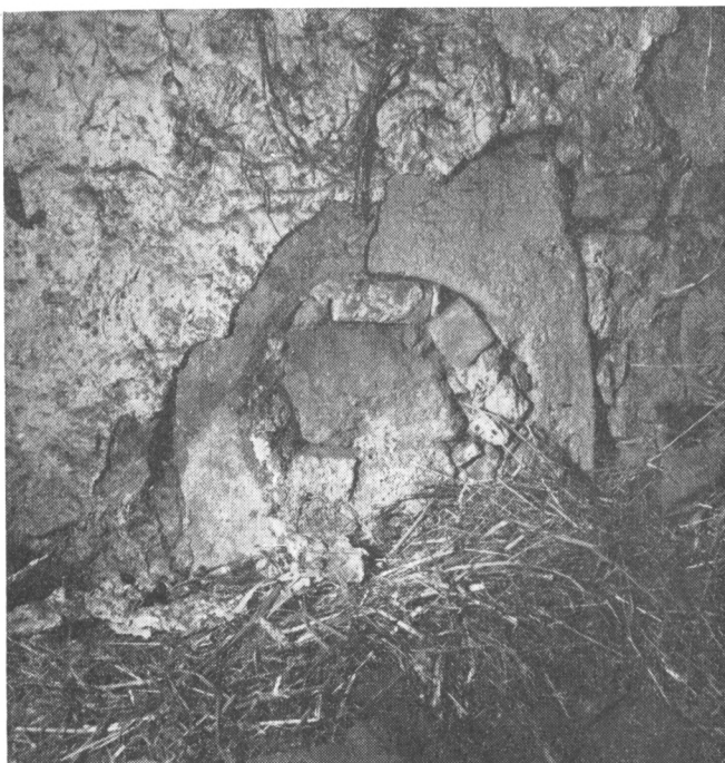
Obr. 11. Bolevec čp. 7. Ostění kruhového okoseného větracího okénka v západní štítové stěně sýpky. Okénko bylo zřejmě zazděno a omítnuto při klasicistní úpravě sýpky na začátku 19. století.
