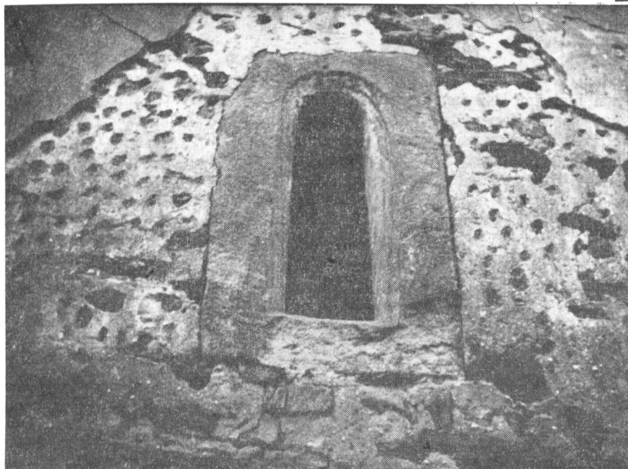
Obr. 5. ZSO Dolany (okr. Plzeň-sever). Kostel sv. Petra a Pavla. 1 – svrchní část severozápadního opěráku lodi zakončená stříškou, 2 – okénko v západním průčelí se zbytky původní omítky v okolí. Foto autor.
