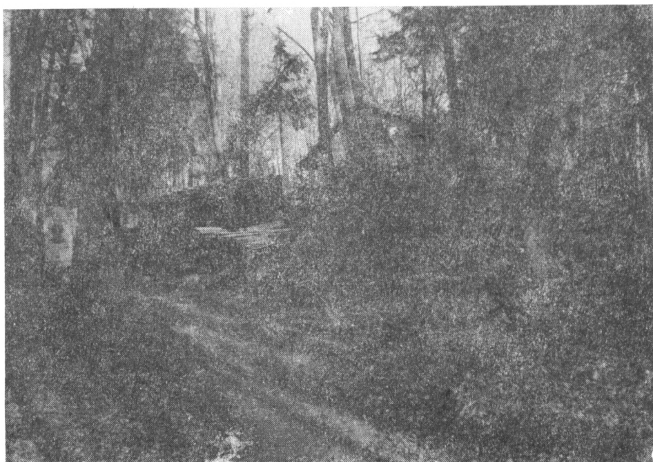
Obr. 3. Opočno u Staré Boleslavi. Pohled do zasypaného obranného příkopu od západu.
