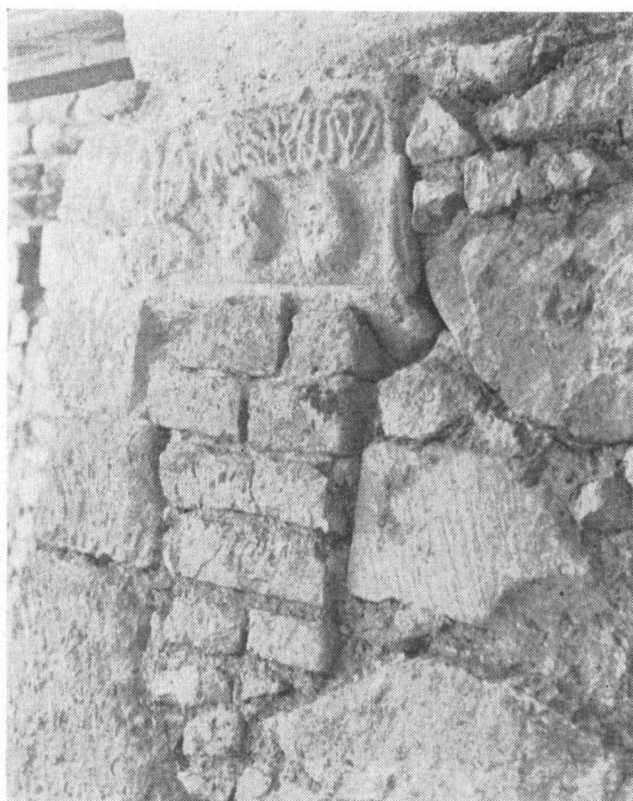
Obr. 2. Severovýchodné nárožie veže so sekundárne zamurovanou reliefnou hlavícou z 11. storočia. Foto Puškárová 1983.
