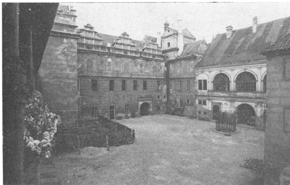
Obr. 13. Hořovský Týn hrad, okr. Domažlice. Jihovýchodní roh nádvoří zámku s objektem starší kaple. Foto: T. Durdík.
