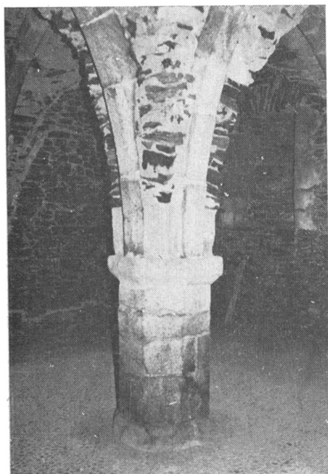
Obr. 16. Horšovský Týn hrad, okr. Domažlice. Střední pilíř severní klenuté místnosti starší fáze poloza-puštěného přízemí západního křídla. Foto: T. Durdík.
