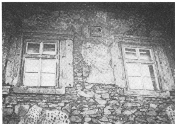
Obr. 13.–14. Banská Štiavnica (okres Žiar nad Hronom). Drobné větrací otvory čtvercového a kruhového tvaru v průčelí domů.
