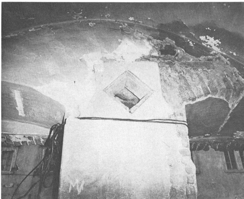
Obr. 17. Banská Štiavnica (okres Ziar nad Hronom). Trojičné námestie. Tesané ostění drobného větracího otvoru kosočtvercového tvaru nad okny, pod valenou klenbou pozdně gotické obytné místnosti.
