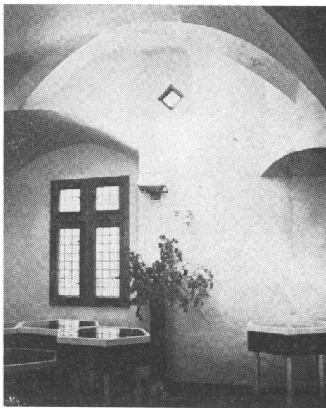
Obr. 11.–12. Kremnica (okres Žiar nad Hronom). Příklady větracích otvorů ve stěnách pozdně gotických domů – šikmé průrazy s omítkovými paspartami a situace otvoru v prostoru, klenutém skřípkovou klenbou.
