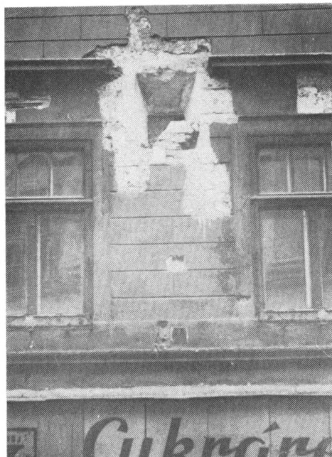
Obr. 15.–16. Banská Štiavnica (okres Žiar nad Hronom). Varianty vnějšího utváření větracích otvorů ve fasádách s šikmými, ven rozevřenými špaletami.
