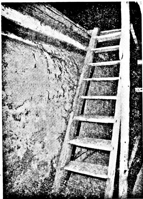
Obr. 6. Čistá čp. 171, horní část roubeného bloku jizby s izolační hliněnou omazávkou, vyčnívající do prostoru horní síně. Nahoře vyrovnávací roubená ohrádka pro usazení krovu, vpravo schody na půdu. Foto J. Škabrada, 1988.
