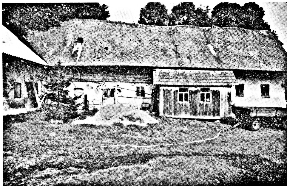
Obr. 3. Čistá čp. 171, dvortkové průčelí domu s novodobou verandou před vstupem a odřízanou pavlačí u zadní patrové části. Vlevo mladší kolmé hospodářské křídlo. Foto J. Škabrada, 1988.
