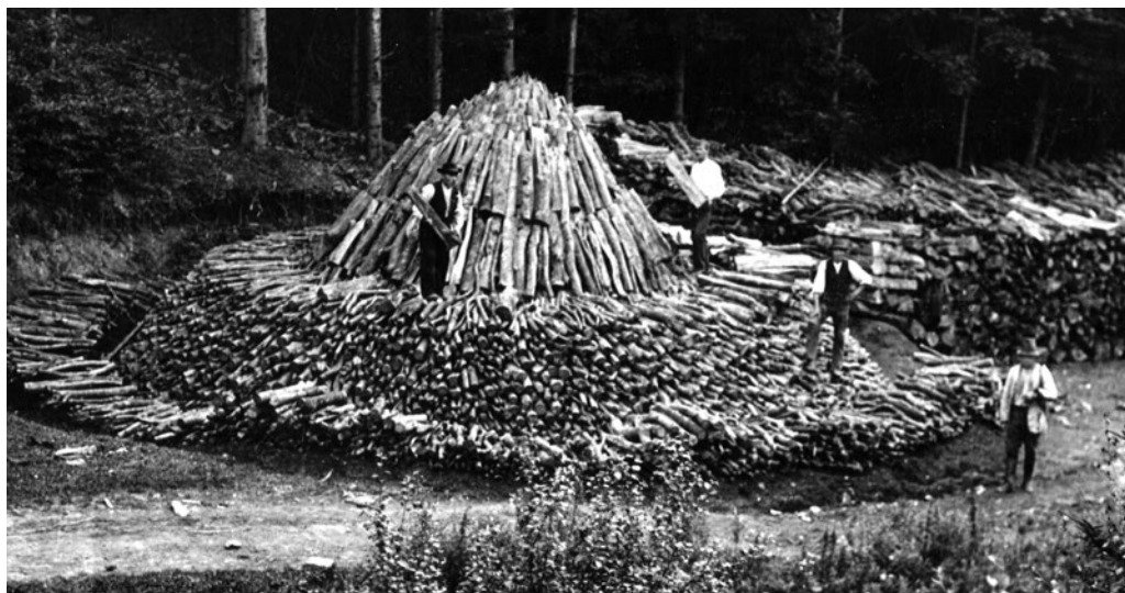
Obr. 10. Zakládání milíře k pálení dřevěného uhlí. Fotoarchiv Muzea regionu Valašsko, Vsetín.
