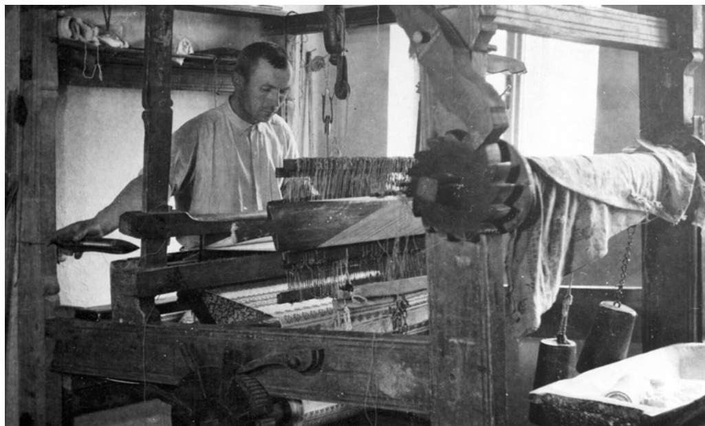
Obr. 14. Tkadlec při práci na tkalcovském stavu. Fotoarchiv Ústavu evropské etnologie FF MU, Brno.
